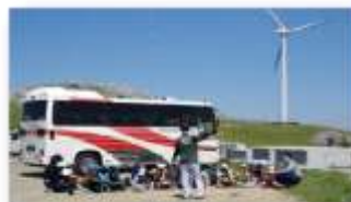
町営風力発電事業 (2基、1200kW)
